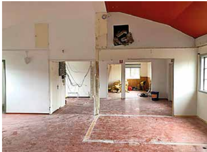
Den 15 mars satte rivningen av väggar igång, för att få en bättre planlösning.
